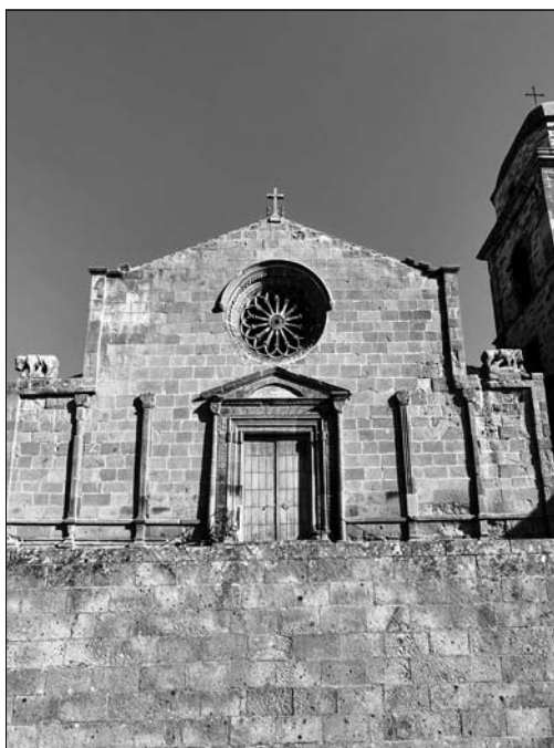
Fig. 12a. Ardauli, Parrocchiale della Beata Vergine del Buon Cammino, prospetto (foto I.S. Fenu).
