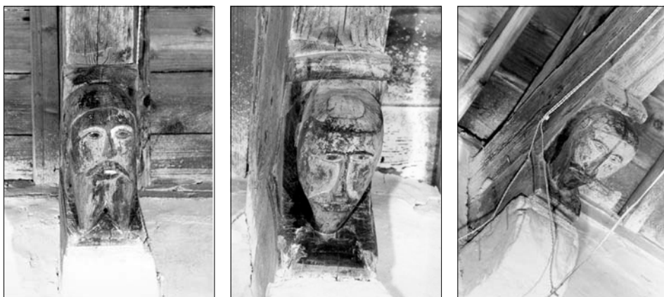
Fig. 29a, b, c. Sanluri, chiesa di S. Lorenzo, navata maggiore, le tre mensole antropomorfe maschili prima del restauro (Archivio fotografico SABAP CA, 35194, 35202, 35181).
