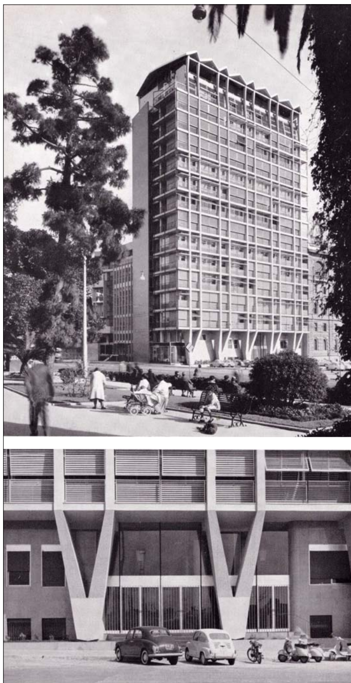
Fig. 4. Gigi Ghò, Sede della Società Elettrica Sarda a Cagliari (Edilizia Moderna, 74, 1961).
