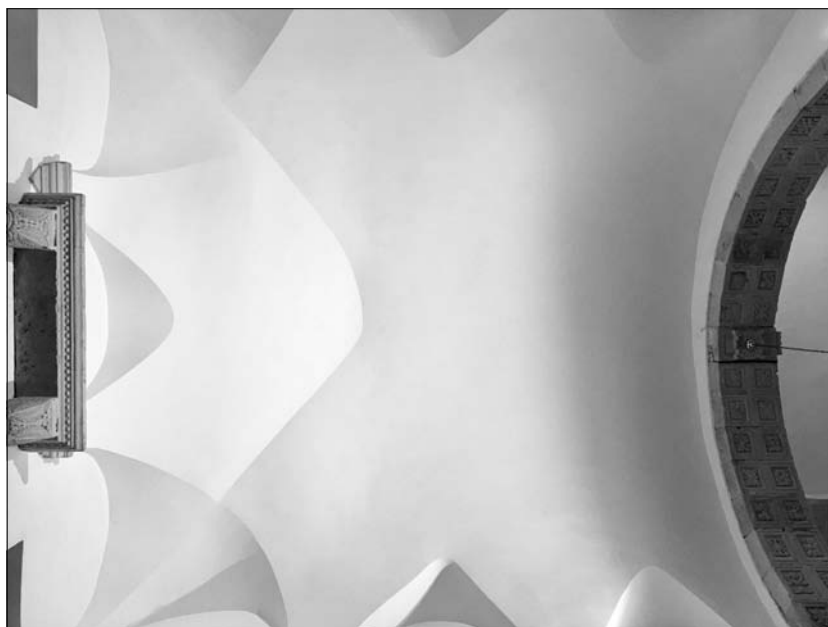
Fig. 10. San Vero Milis, Parrocchiale di Santa Sofia V. e M., navata sinistra, volta a padiglione (foto I.S. Fenu).
