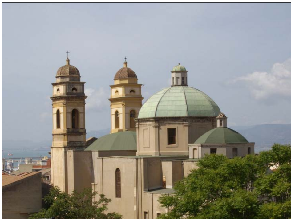
Fig. 7. Cagliari, chiesa di Sant'Anna, coperture attuali delle cupole e delle volte.
