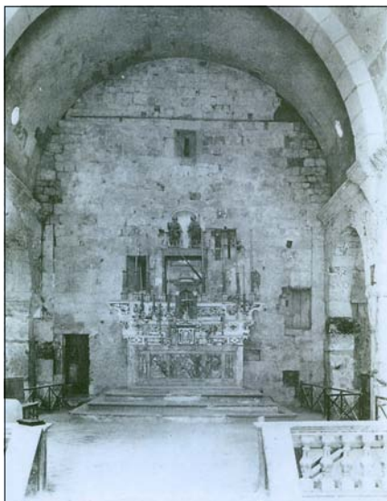
Fig. 5 - Interno della Basilica prima dei restauri del 1930; l'area presbiteriale è ancora cinta dalla balaustra, l'abside è tamponata ed è ancora presente l'altare in marmi policromi sopra il quale spiccano le due sculture lignee raff. i SS. Cosma e Damiano, mentre la nicchia, un tempo chiusa da una vetrata e contenente il simulacro di S. Saturnino, appare ormai vuota
