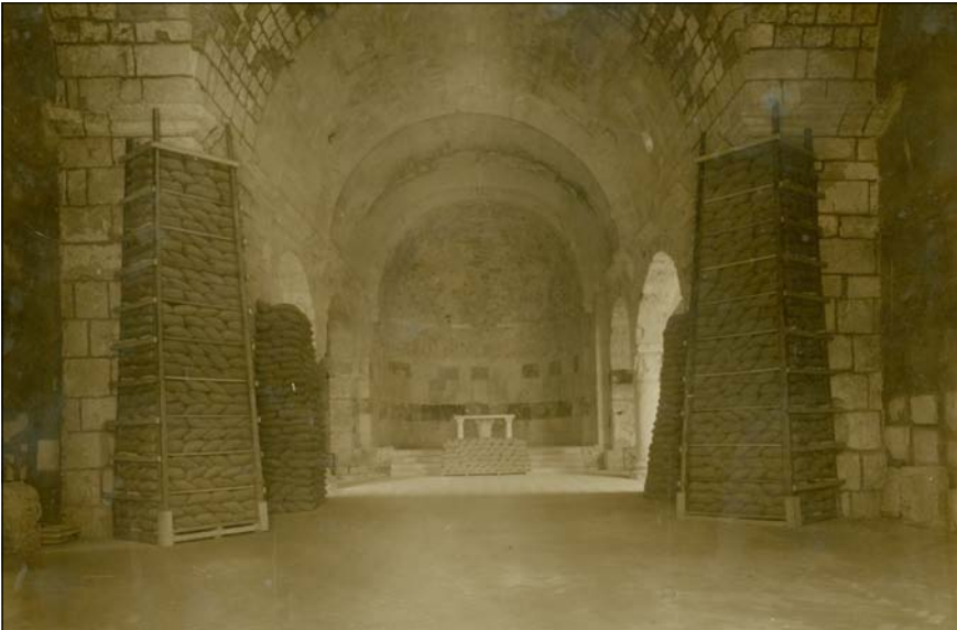
Fig. 11 - Interno della Basilica: protezione antiarea fatta predisporre da R. Delogu durante la 2ª Guerra Mondiale
